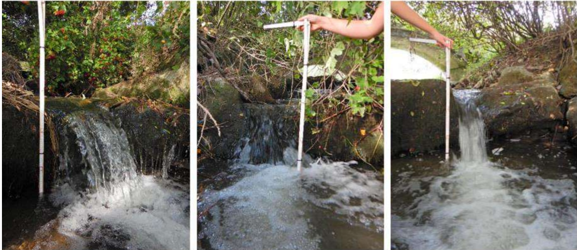
Abbildung 16: Die drei Abstürze im Mündungsbereich (von oben nach unten). Aufnahmen der Fish Consulting GmbH.
