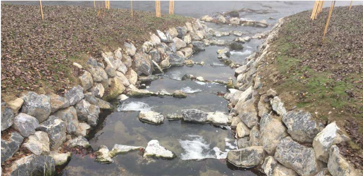
Abbildung 39: Riegelrampe mit Schwellen-Becken-Sequenzen im Mündungsbereich des Lattenbaches in die Thur.
