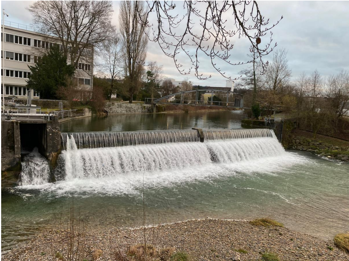
Abbildung 1: Streichwehr des Ausleitkraftwerkes Obertöss in Winterthur mit geöffneten Klappen. @T. Gross
