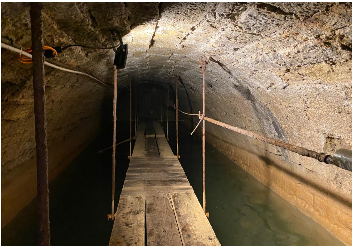
Abbildung 2: Der Rieterkanal bringt das Wasser teils unterirdisch zum KW Untertöss. @T. Gross
